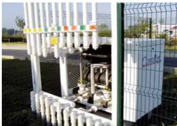
Le bloc de recondensation équipé d'échangeurs thermiques tubulaires.
